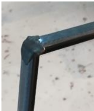
Angle plié recouvert de butyl
