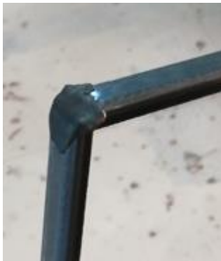
Angolo piegato con ricopertura di butile
